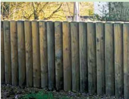
Zylindrisch gefräst, gefast und kesseldruckimprägniert, Farbe grün
