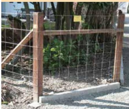
Drahtgeflecht «Ursus» schwer, aus stark verzinkten Drähten, inkl. Drahtspanner montiert auf druckimprägnierten Holzpfosten oder feuerverzinkten Rohrfosten Pfostendistanz ca. 4,00 m.
